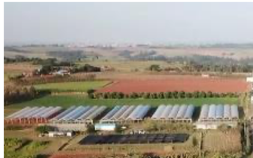
Figura 16: Tanque de captação de água de chuva.
